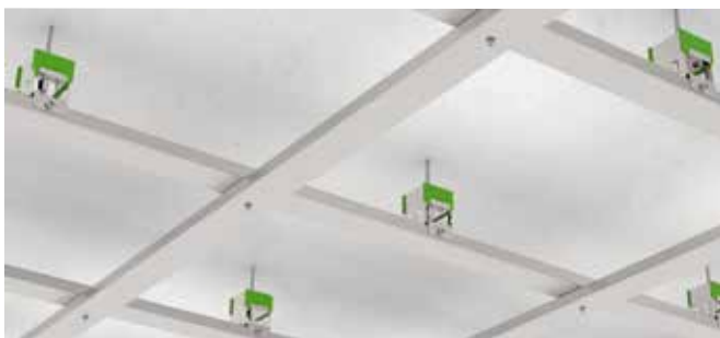
11.- Fix transverse profiles.
